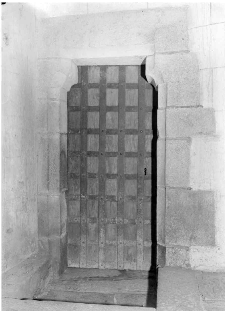
Sacristie, détail de la porte
