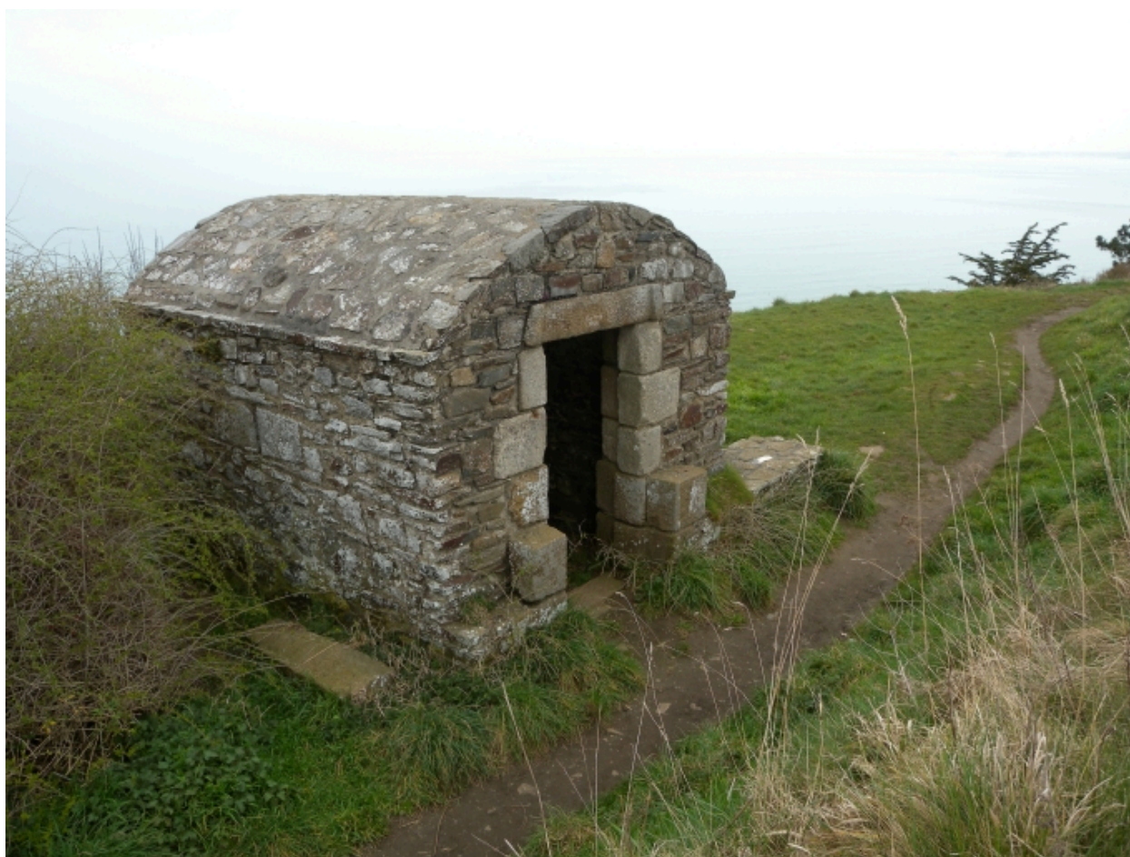
Vue de la façade Sud du corps de garde, en lisière du sentier
