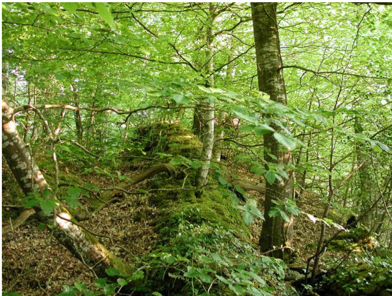
Vue d'un talus-mur
