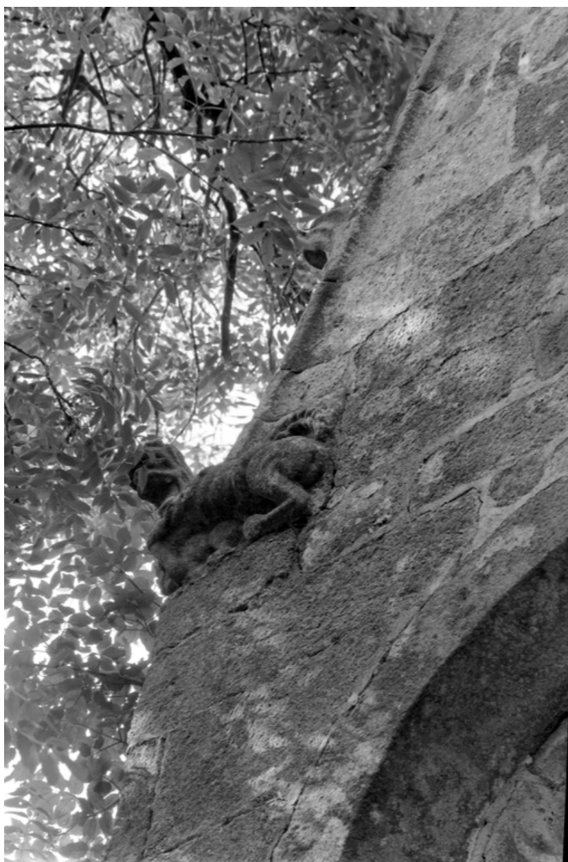
Mur nord du bras nord du transept : détail de la pierre d'assise du rampant est
