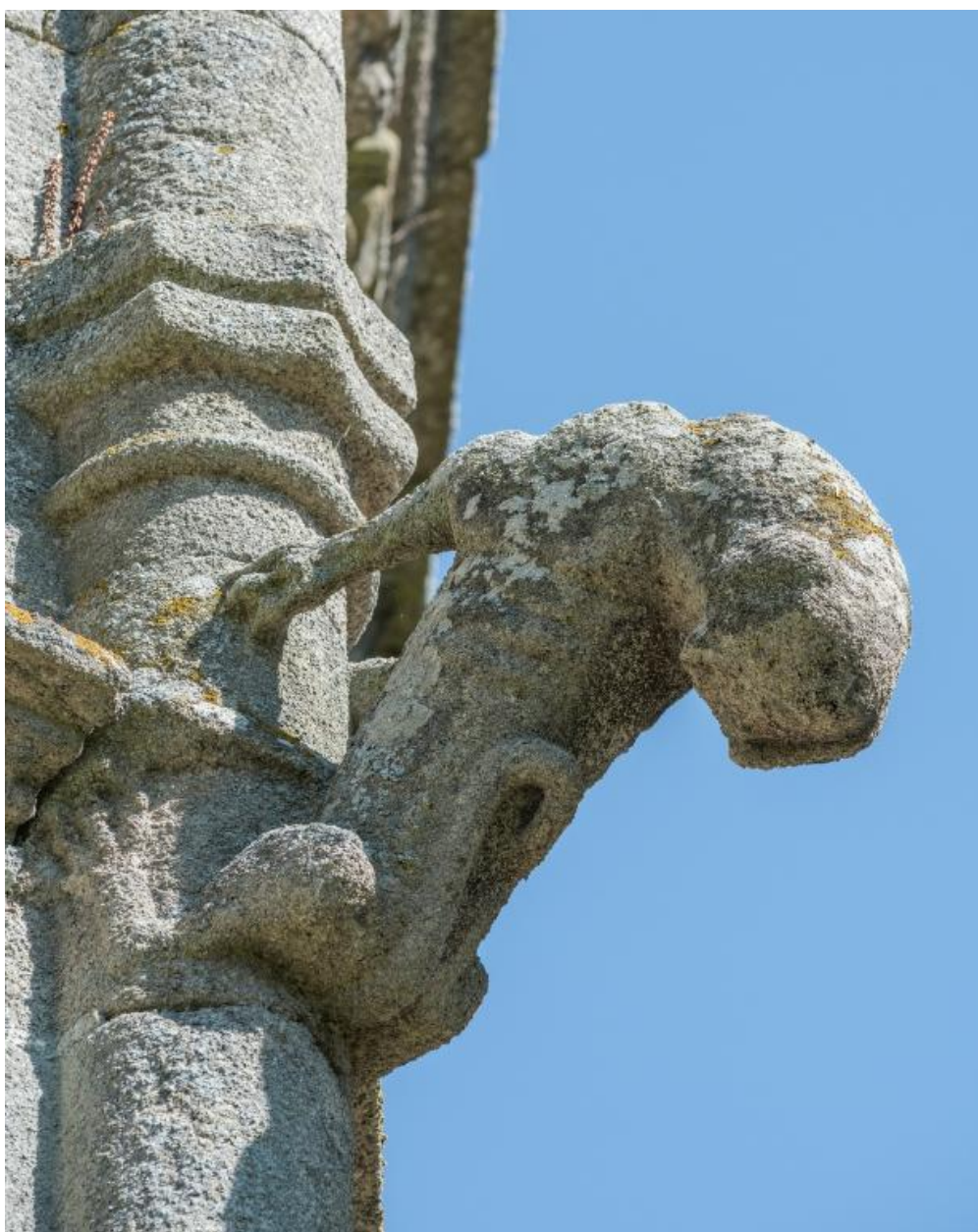
Tour d'escalier, détail d'un décor sculpté
