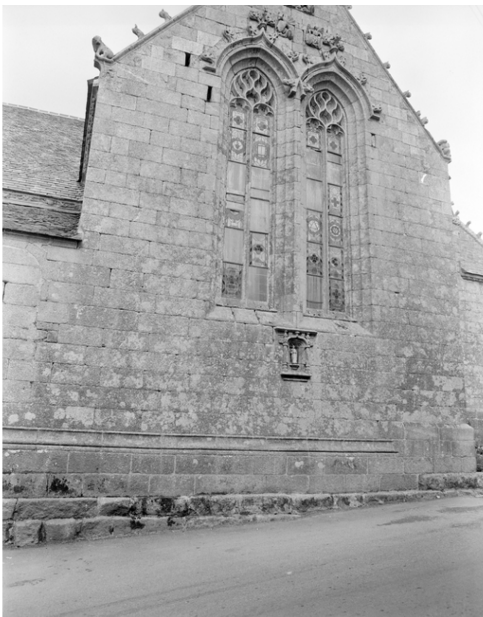
Choeur, mur est : vue des fenêtres jumelées
