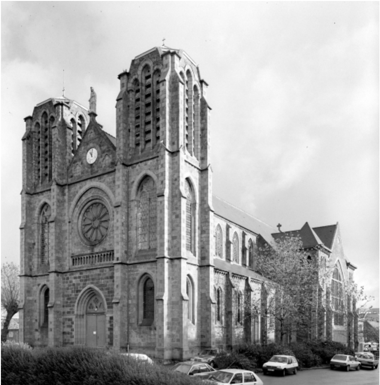
Elévation Sud-Ouest : vue générale
