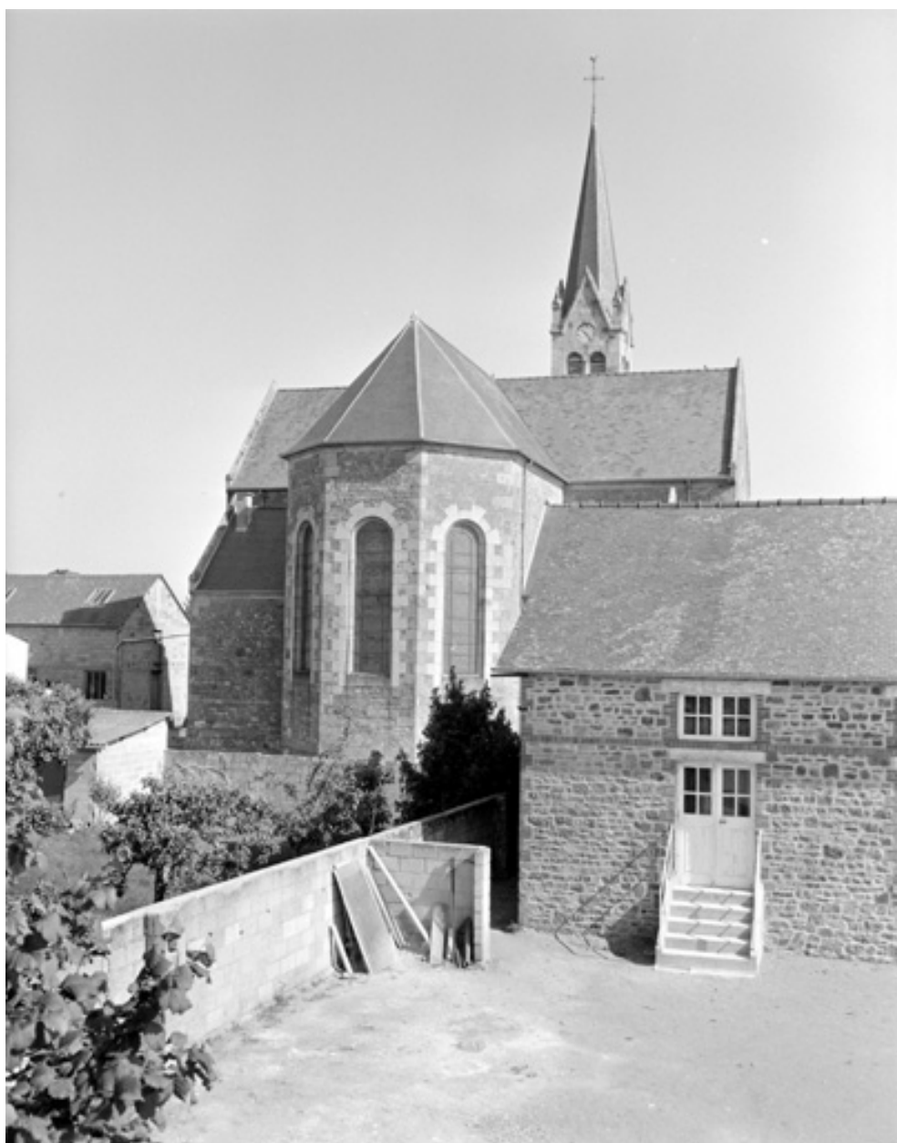
Élévation Sud : vue générale
