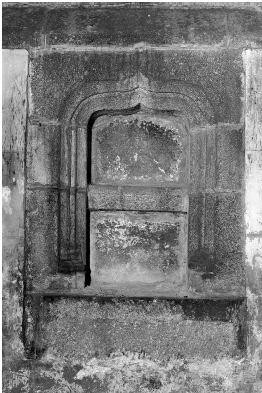
Nef, mur sud : détail de la crédence
