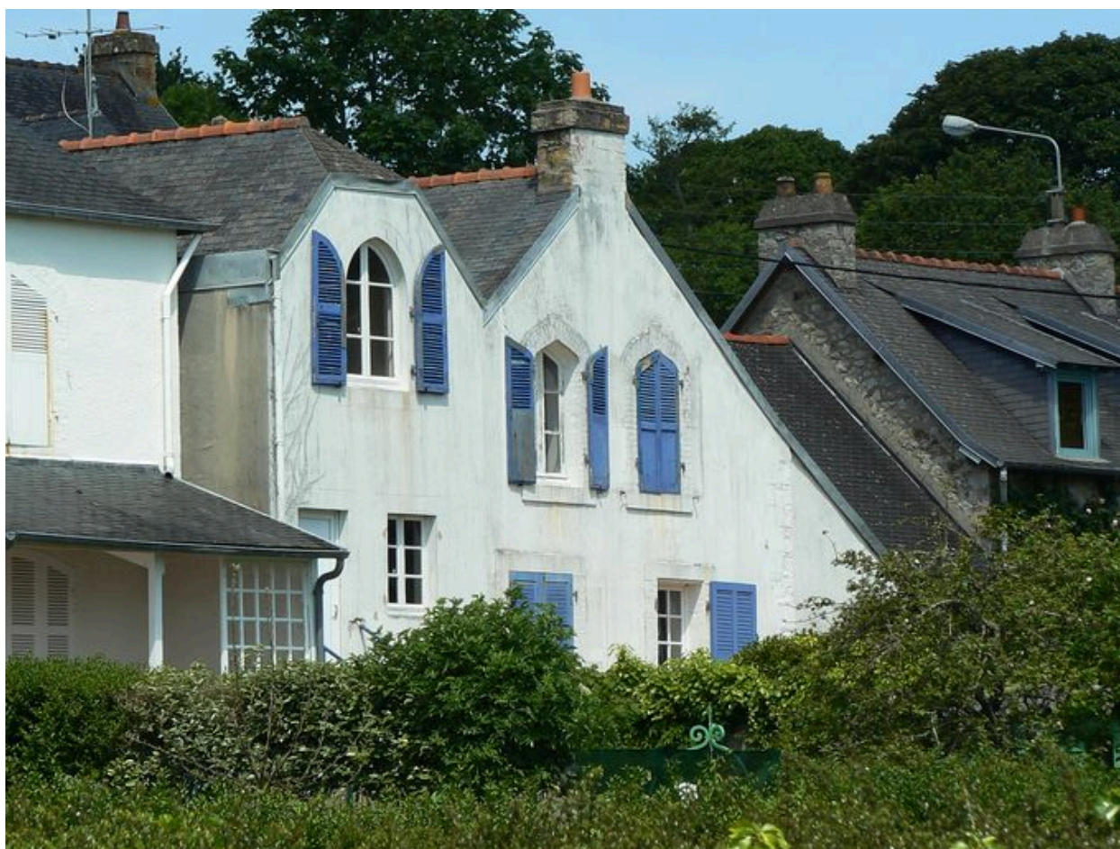
Vue générale de la villa Ker Eulec'h, côté mer
