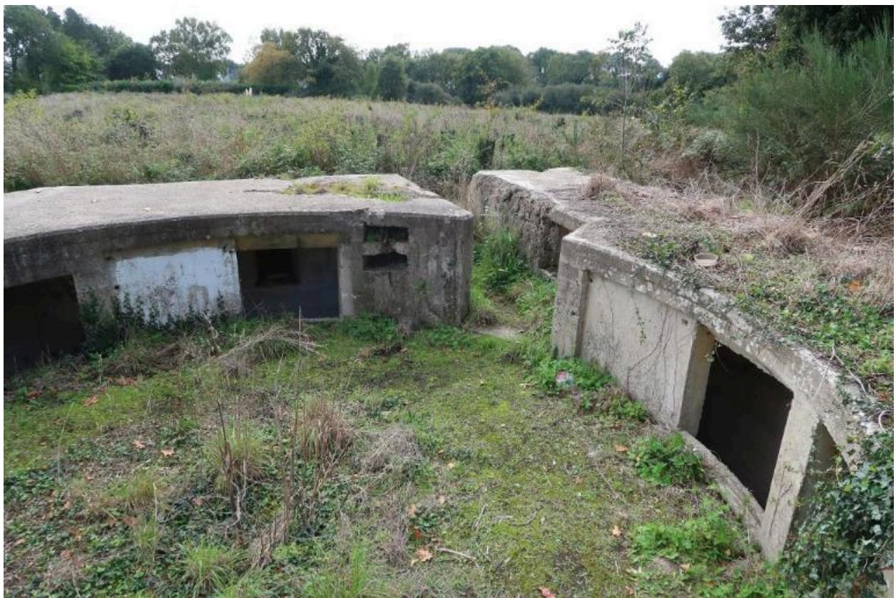
Vue du bunker-cuve de type Fl243a (V) pour canon antiaérien de 10.5 cm : au centre, l'entrée orientée vers le sud ; à gauche de l'entrée, petit espace abritant l'ouverture de tir défendant l'entrée ; autour de la cuve circulaire sont implantées sept niche
