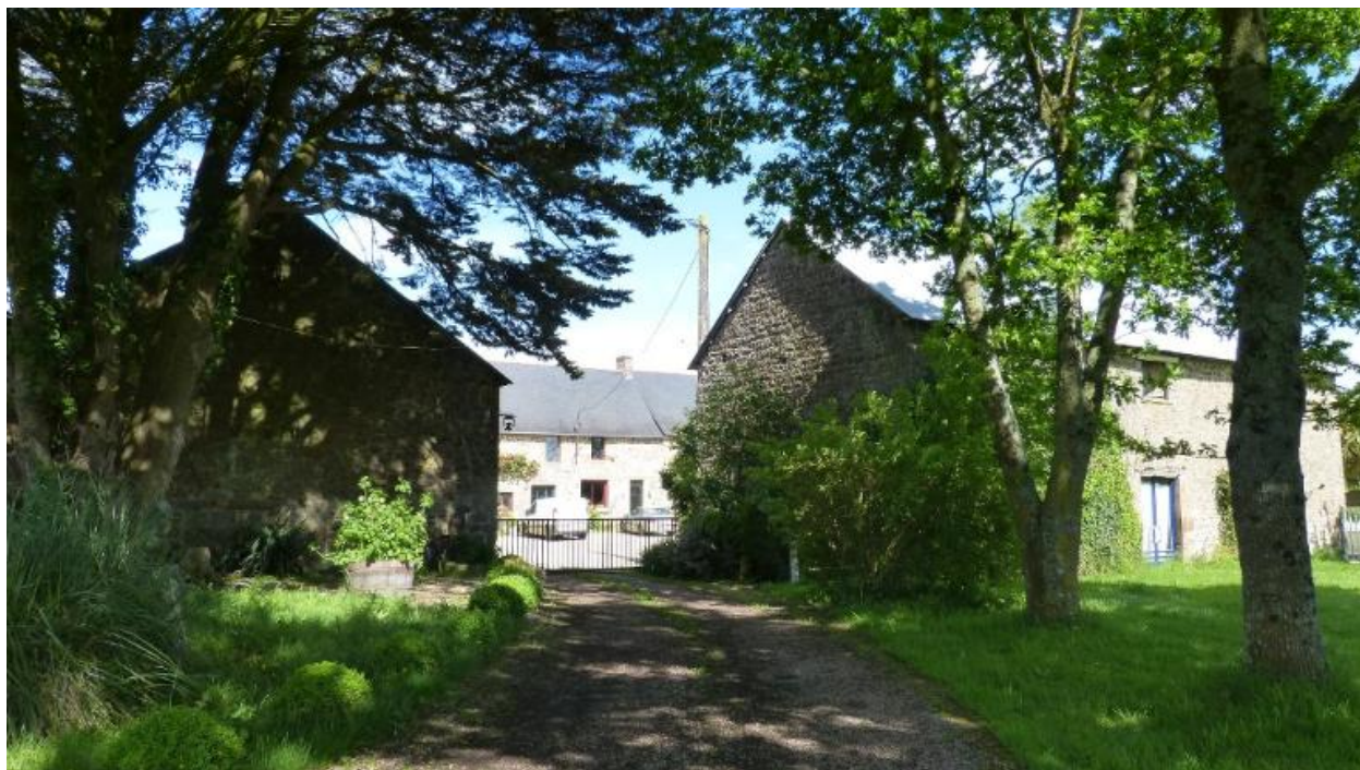
Vue d'ensemble ouest
