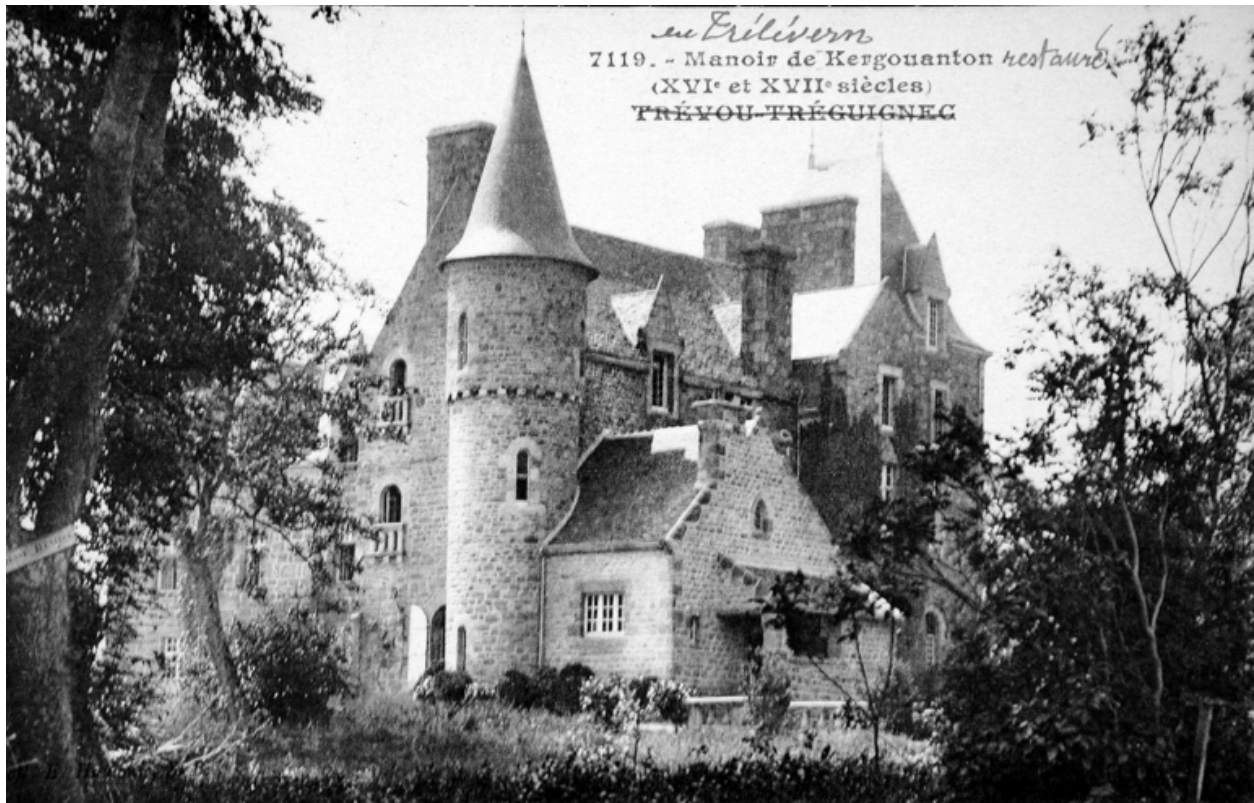
Vue générale après restauration
