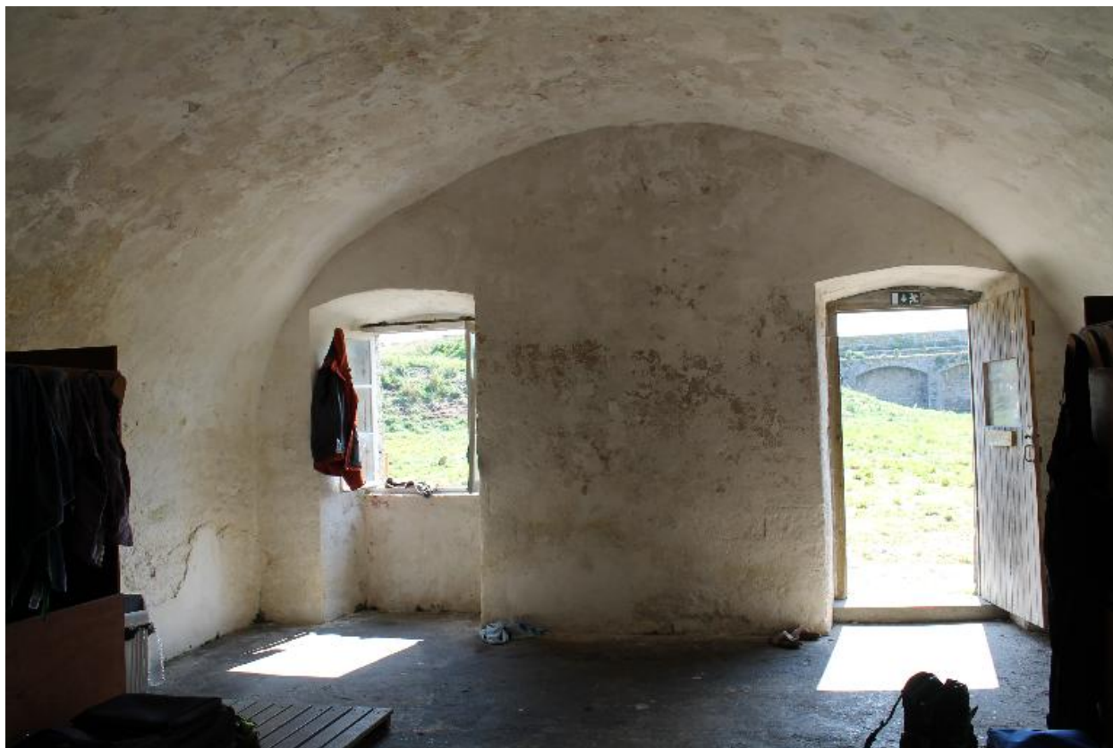
Intérieur d'une casemate
