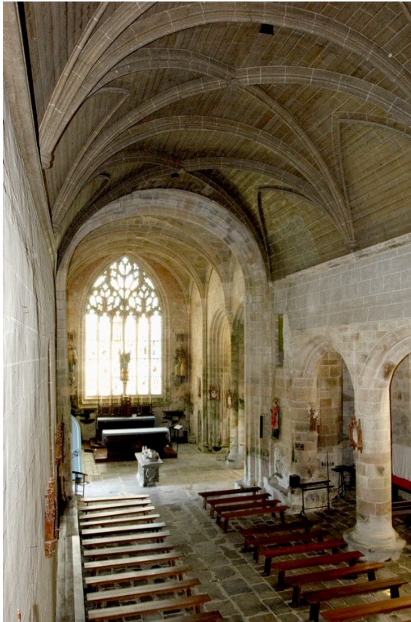
Intérieur, vue de la nef vers le choeur.
