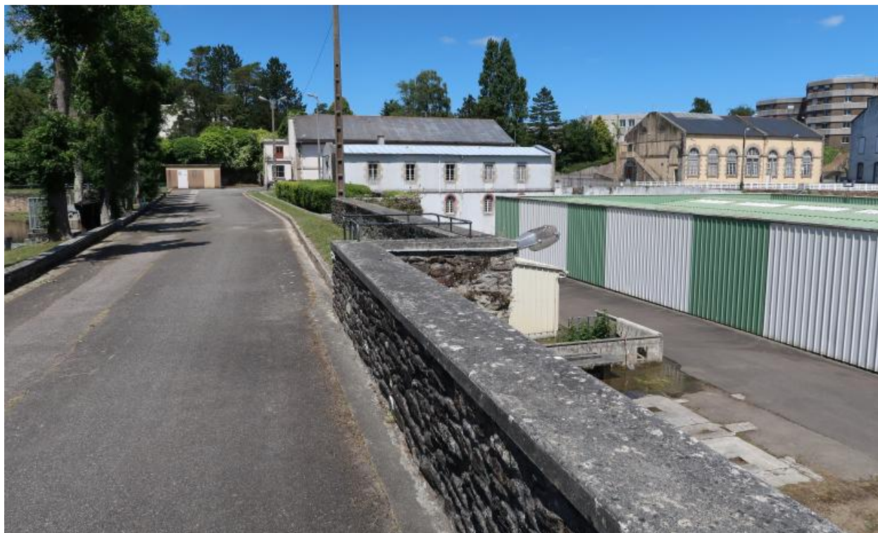
Vue générale de la digue vers le nord (état en 2022). Au centre et à droite, anciens bâtiments des forges
