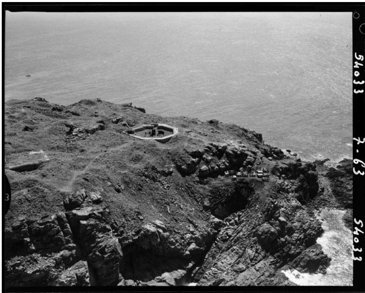
Vue aérienne oblique de l'Île de Cézembre, 1963
