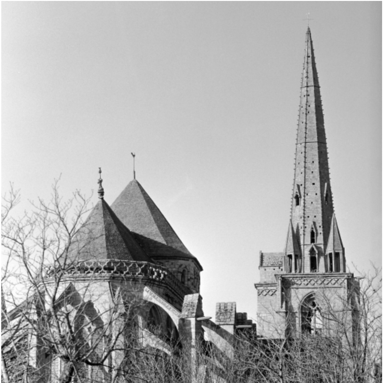
Elévation Est, clocher, flèche : vue générale
