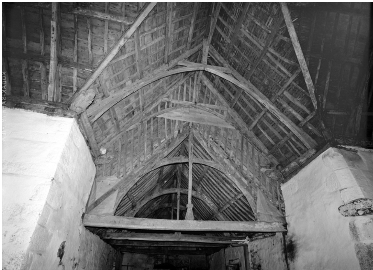
Vue de la charpente de la nef
