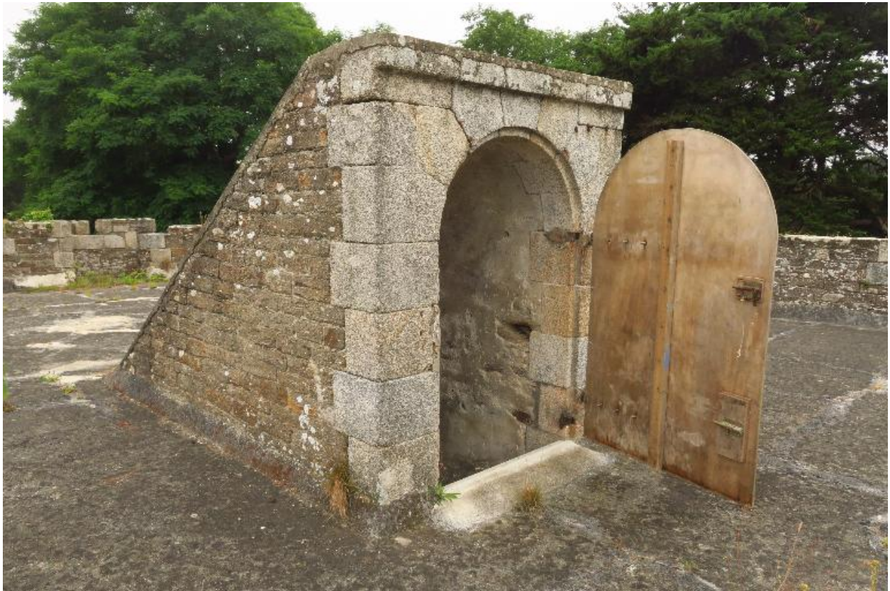
Groix, batterie du Gripp, corps de garde crénelé, débouché de l'escalier sur la terrasse.
