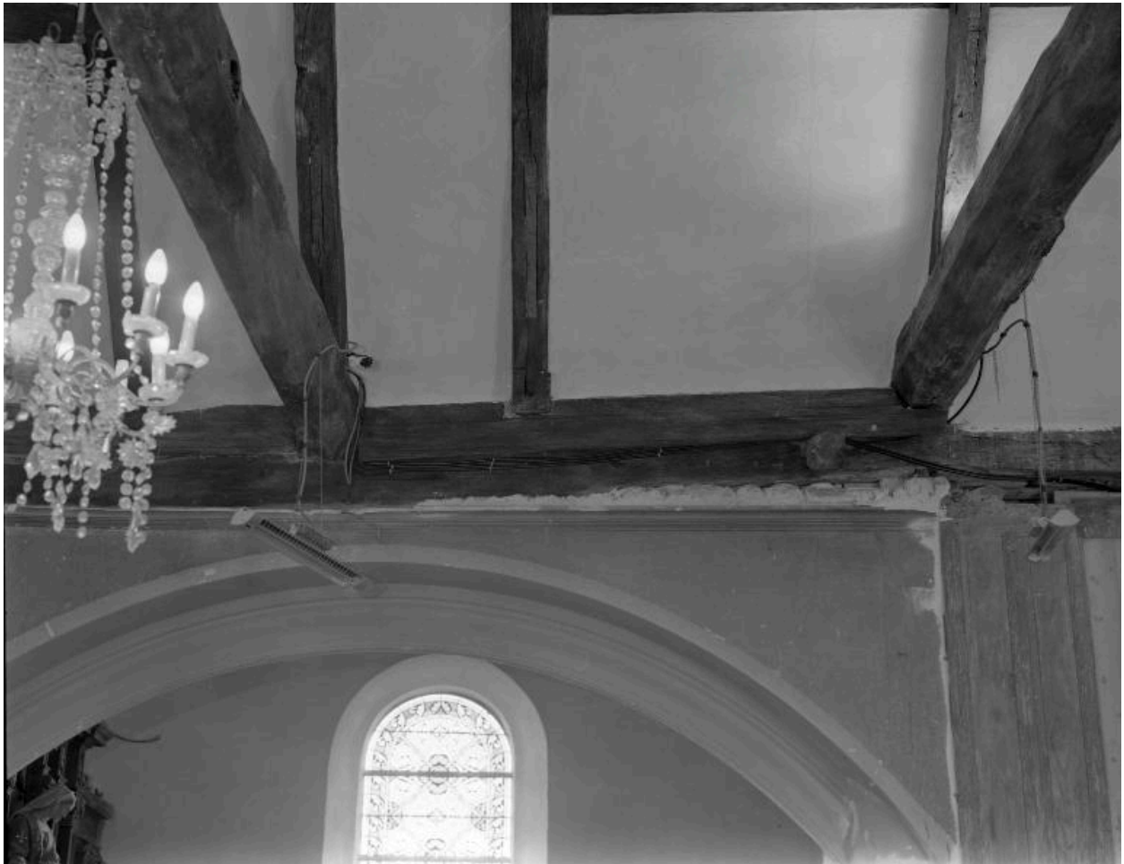
Vue intérieure, sablières, état vers 1980
