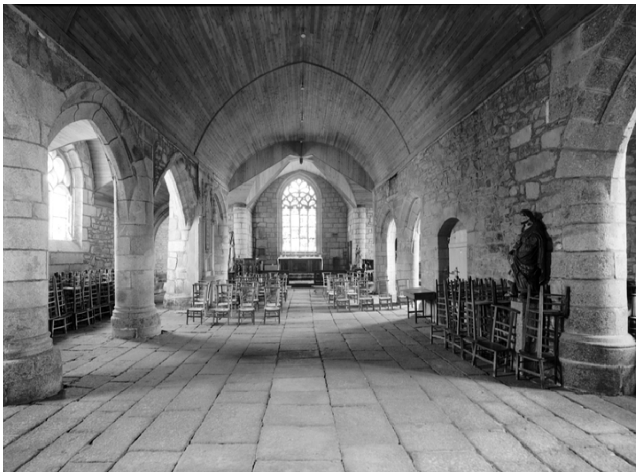
Vue intérieure vers l'est
