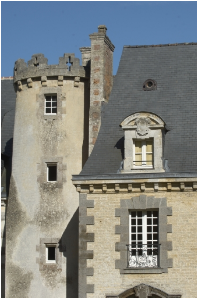
Logis, façade arrière, détail
