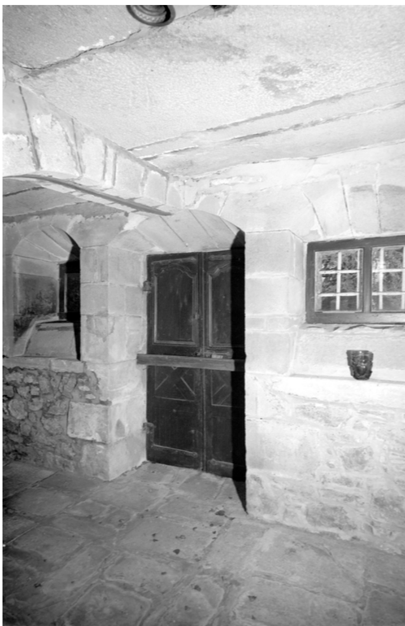
Ouvertures de la façade nord : vue intérieure
