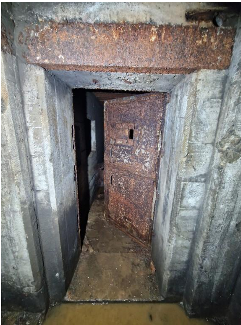
Vue de la porte blindée à deux vantaux de l'entrée nord du sas
