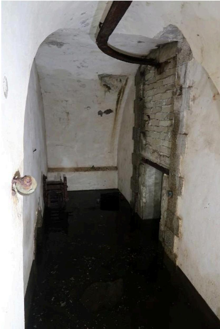
Vue du vestibule côté escalier : suspendu au plafond, le rail permettait la manutention des obus via un treuil. Au fond, le treuil manuel à tambour. Le magasin est partiellement inondé
