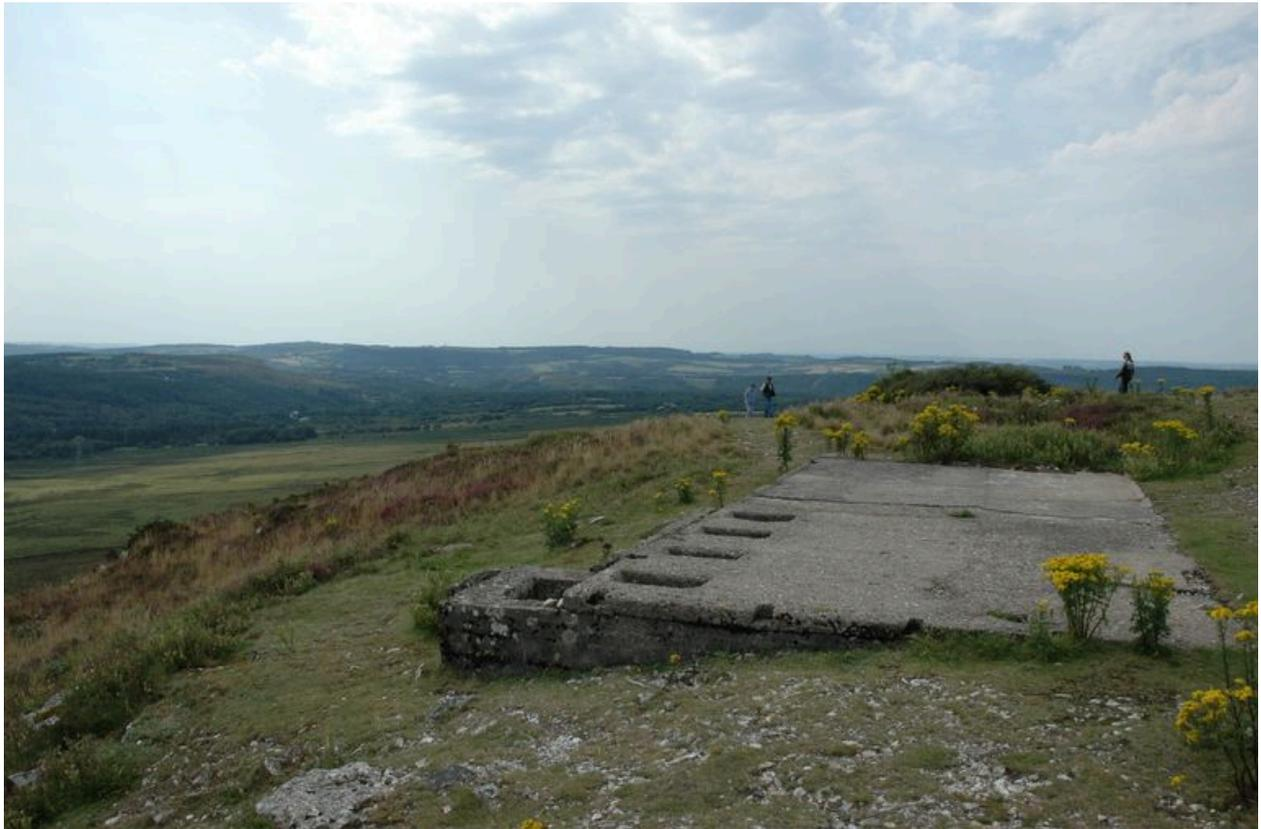
Vue de l'un des bunkers en construction de campagne (état en 2004). Sa dalle de couverture en béton de faible épaisseur est percée de quatre ouvertures
