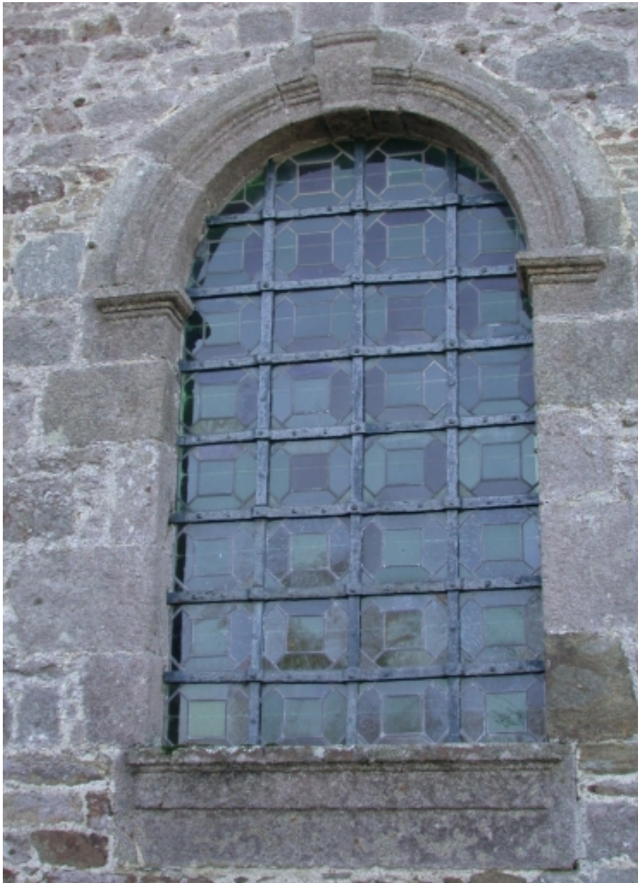
Deuxième chapelle nord, (baie 5)
