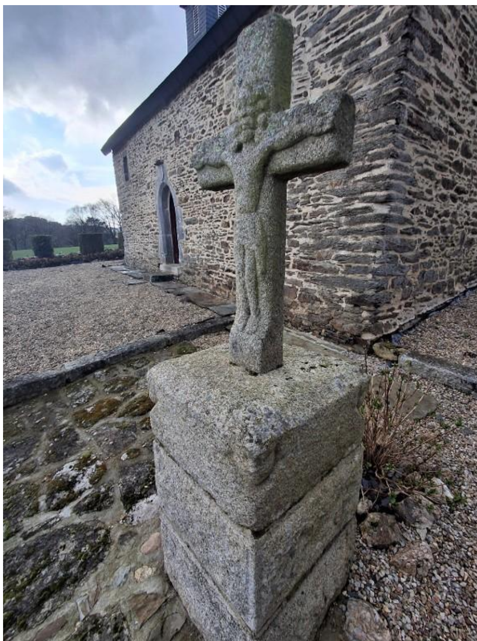
Vue sud-est de l'édifice.
