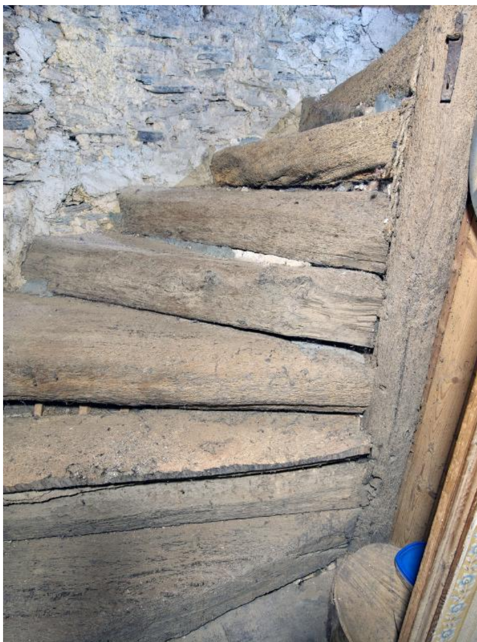
Logis 17e siècle. Escalier en vis. Volée de marches menant au grenier
