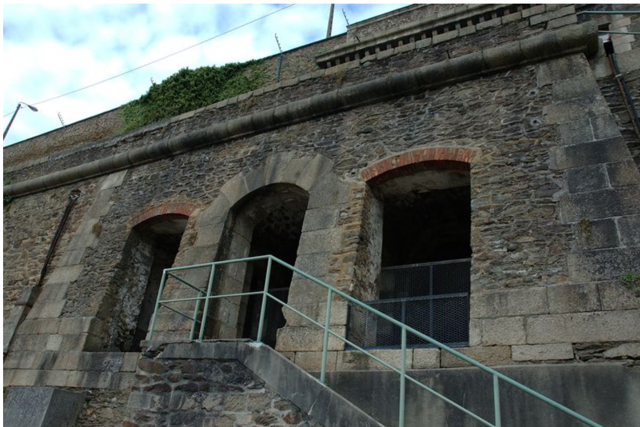
Vue des latrines collectives (contre-plongée)
