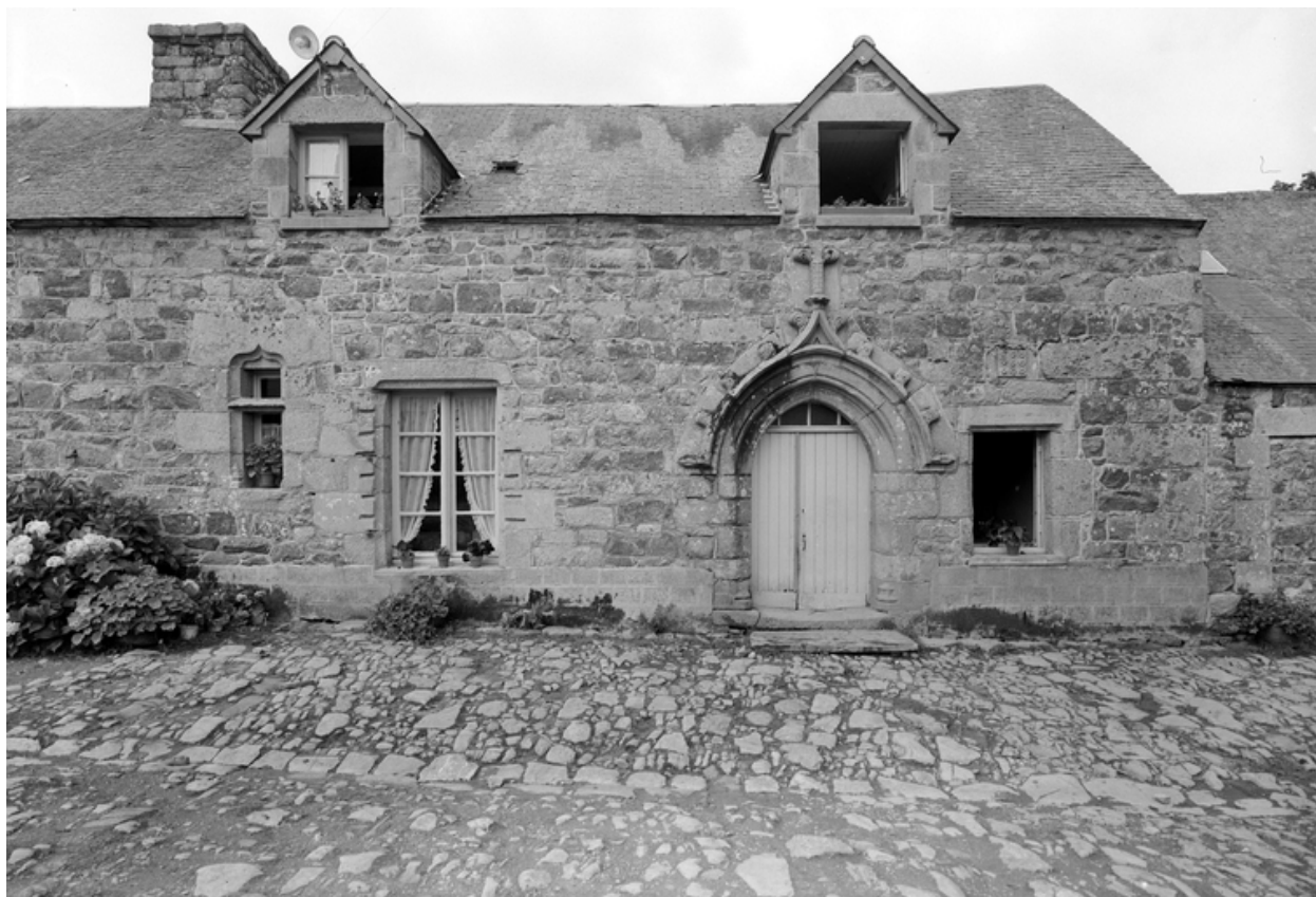
Vue de la face sud
