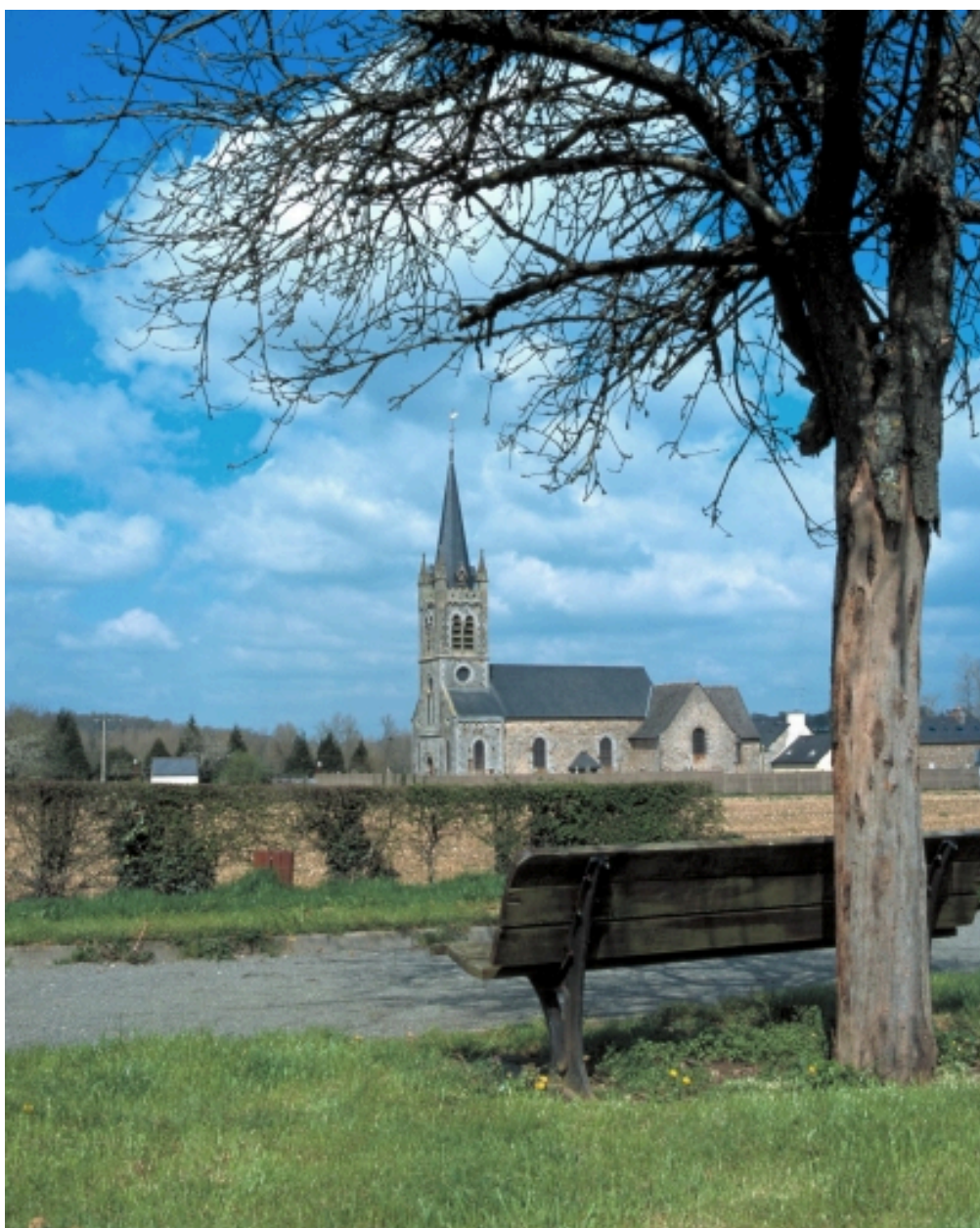
Vue de situation sud-ouest
