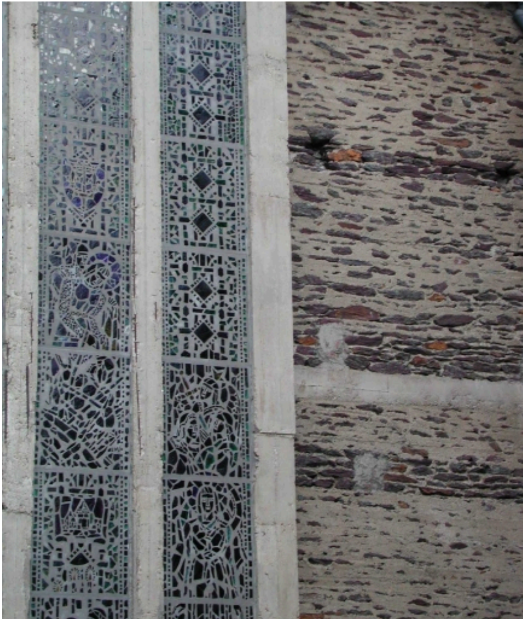
Détail sur le mur ouest
