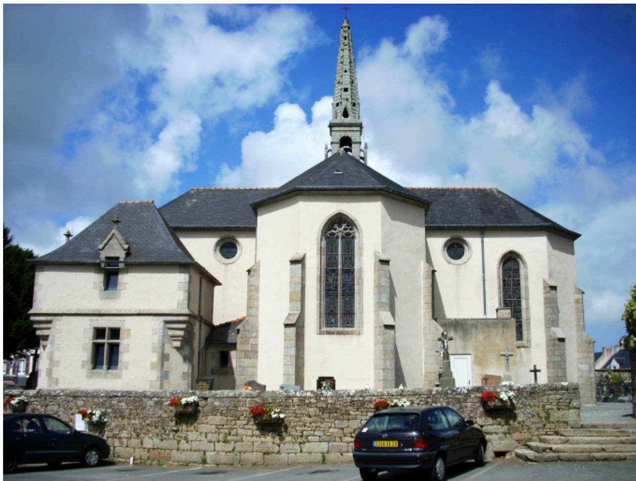
Kernilis, église paroissiale : élévation est
