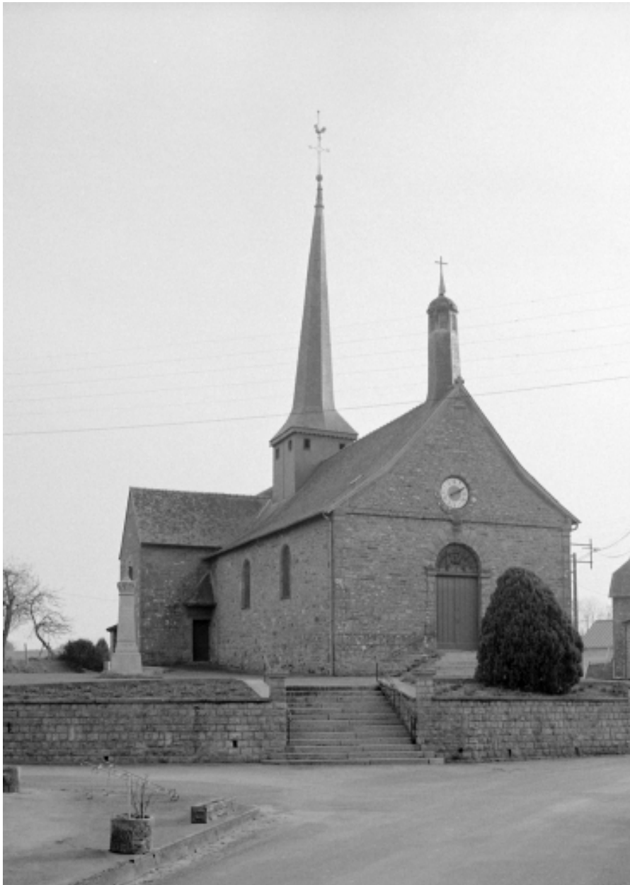
Elévation Ouest : vue générale
