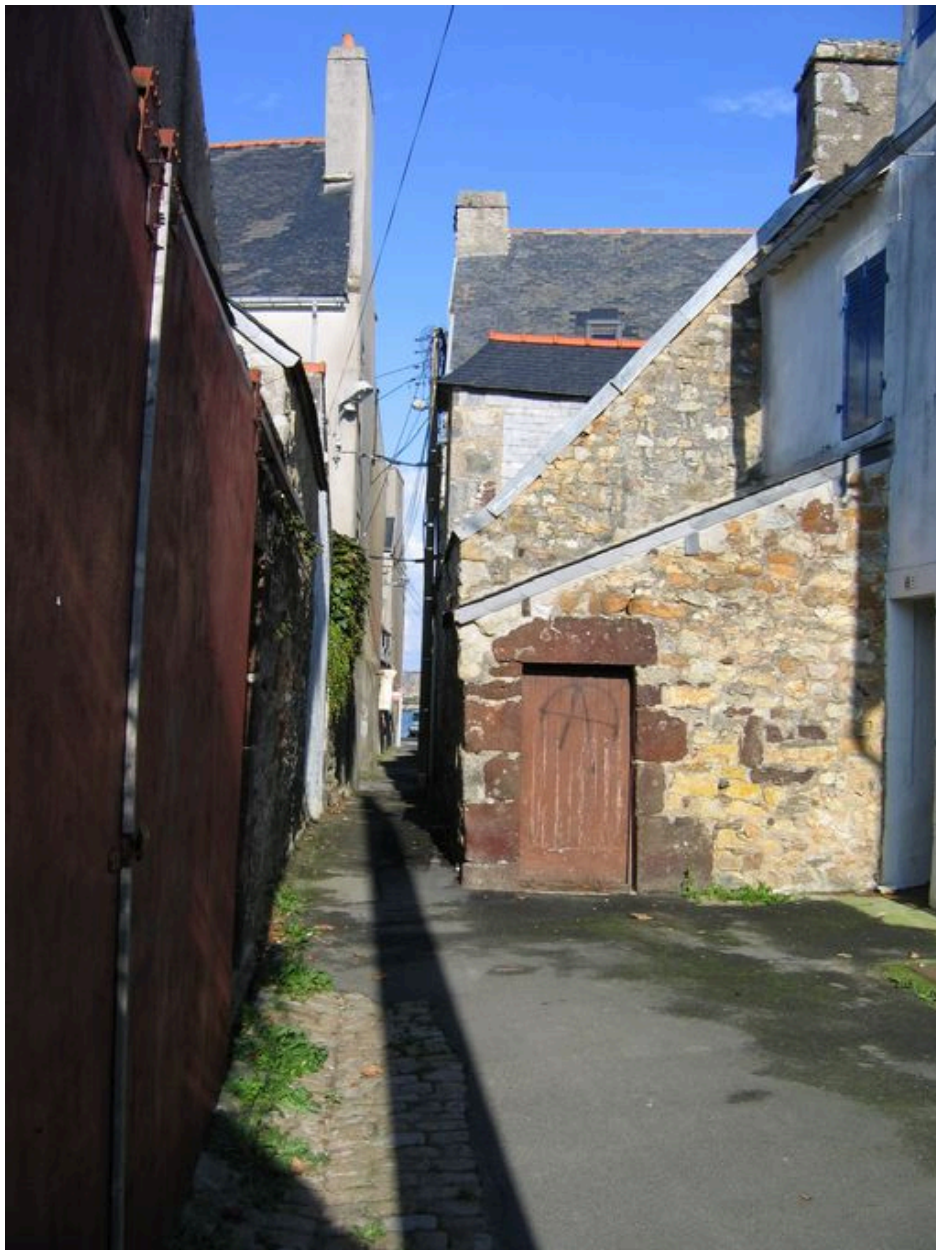
Vue générale de la rue de Bruxelles
