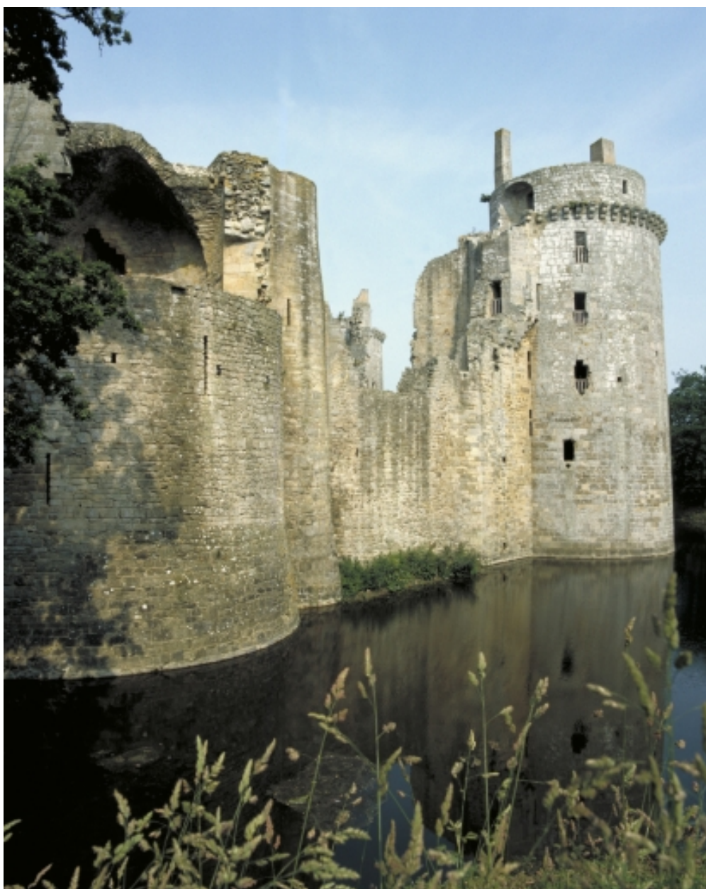
Courtine est, vue générale
