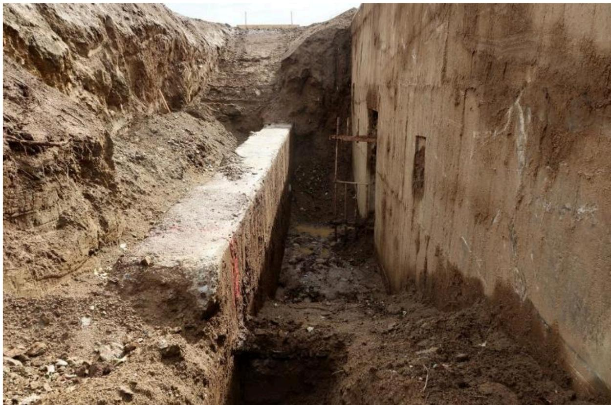
Vue générale depuis le nord : à gauche, mur de soutènement de la tranchée d'accès ; au fond, une bouche de ventilation et l'entrée nord
