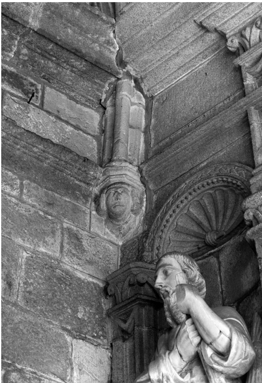
Porche sud, intérieur : angle nord est, détail du cul de lampe
