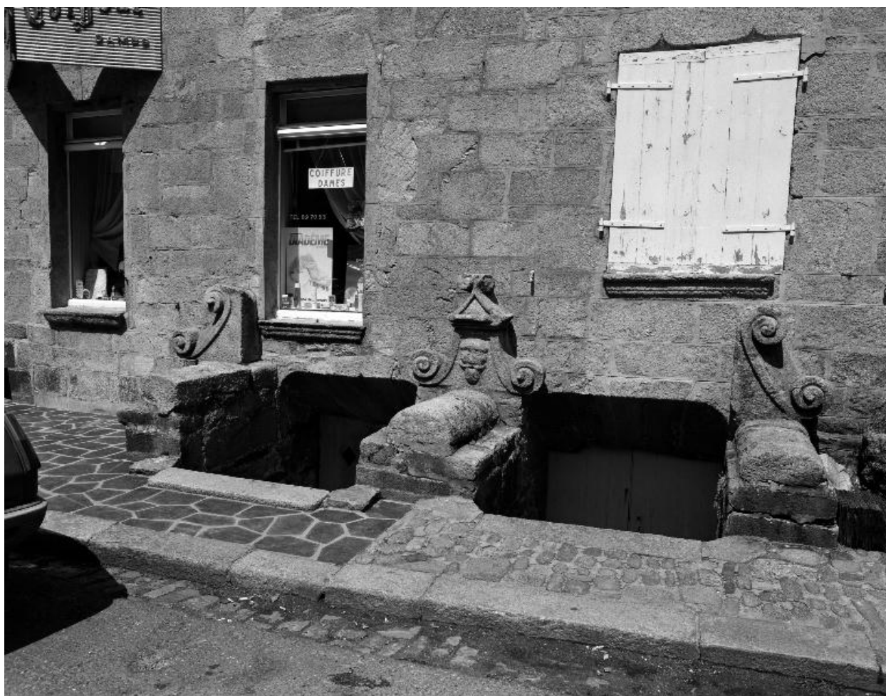
21-23 place Lacaze-Duthiers, élévation sud, détail entrées de caves
