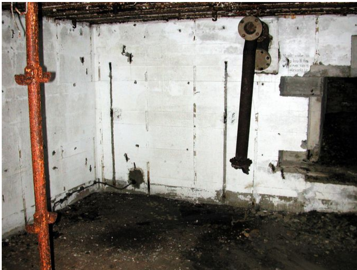
Landéda, île Cézon : abri pour un groupe de type 501 du fort Cézon, vue intérieure. Les supports des couchettes tubulaires et le tuyau du poêle sont encore en place
