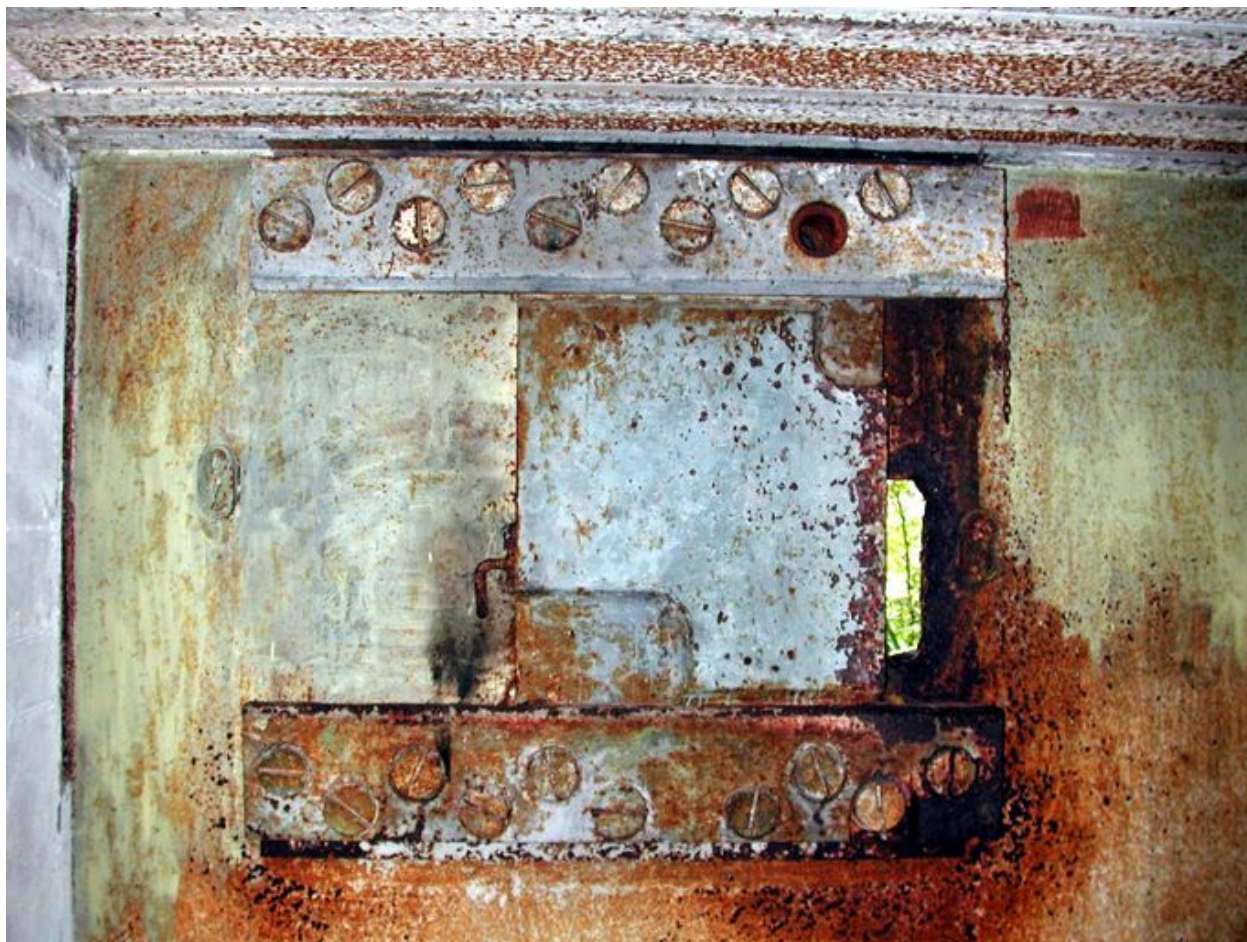
Vue intérieure : créneau blindée (état en 2002)
