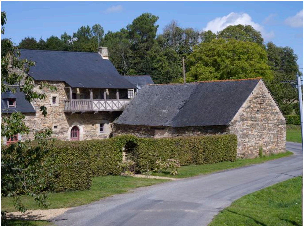
Manoir : vue générale prise du sud-ouest (état en 2011)
