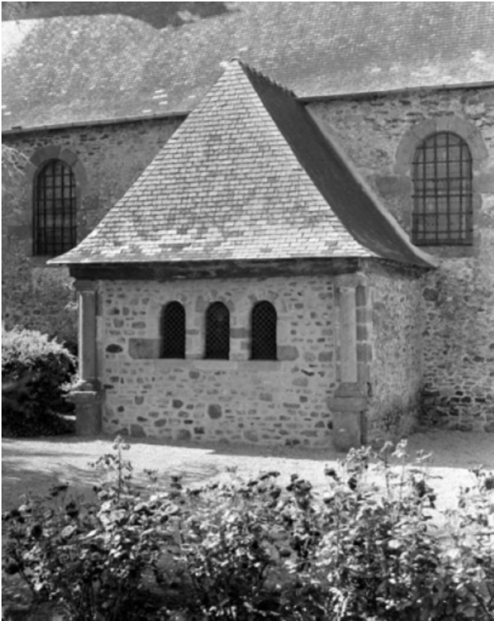
Elévation sud, ancien porche
