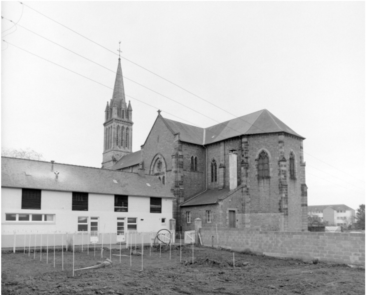
Élévation Nord-Ouest : vue générale
