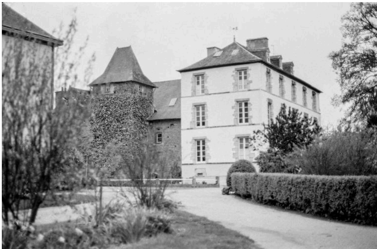
Vue nord (état en 1974)
