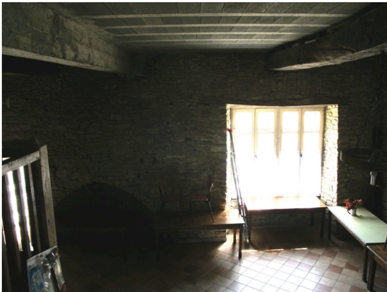
Communs au nord de la cour, partie ouest, mur sud du rez-de-chaussée
