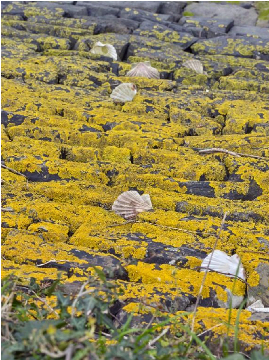
Avant-port, perrés du Quai Surcouf
