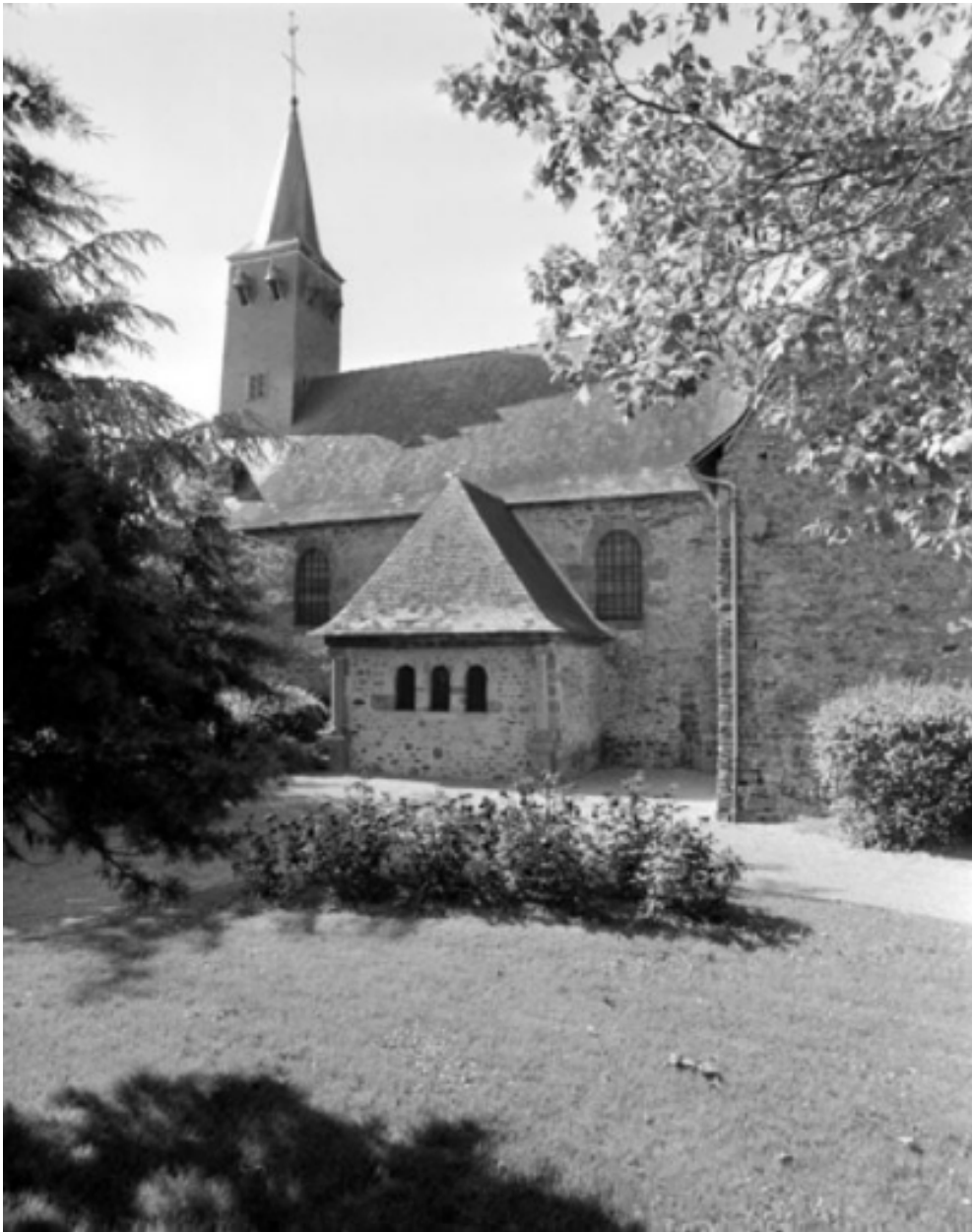
Elévation sud : vue générale
